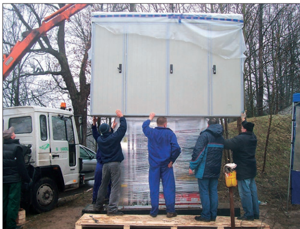
Szafa w trakcie rozbudowy
