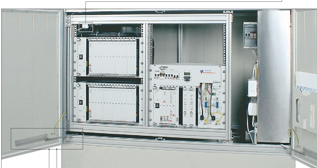
Ogranicznik otwarcia drzwi i wyłącznik krańcowy w szafie z przykładowym wyposażeniem
