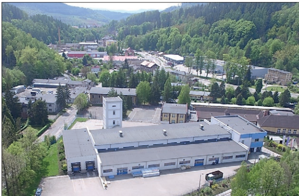
Nowa Ruda, Górnicza Str. Fertigungsstandort für Outdoorgehäuse
