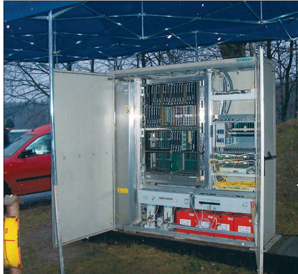
Шкаф перед реконструкцией
