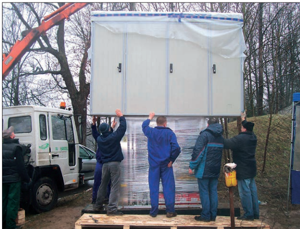
Шкаф в период реконструкции
