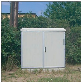
Шкаф перед реконструкцией
